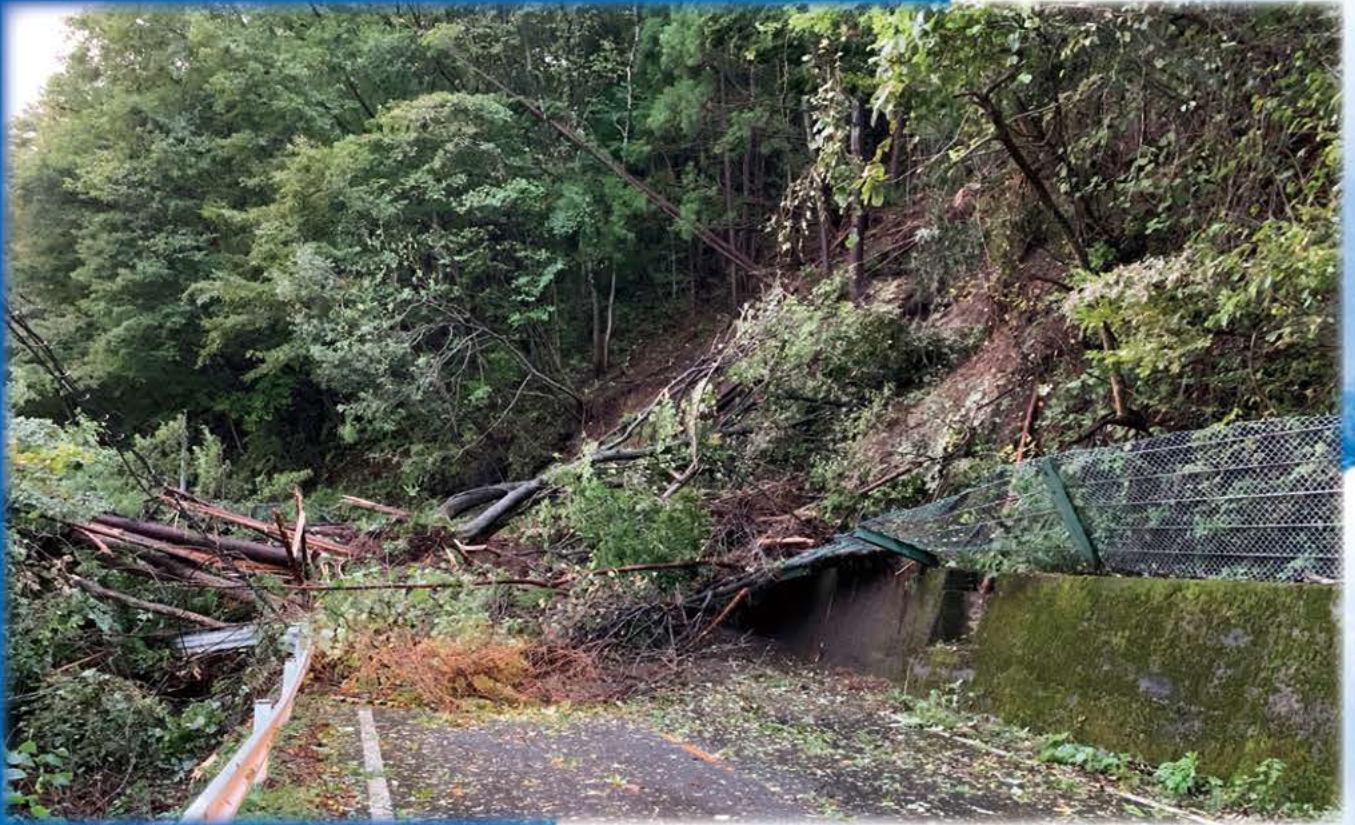
(令和元年東日本豪雨大規模崩落)
