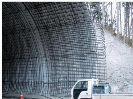
坑口部の覆工は鉄筋コンクリート
