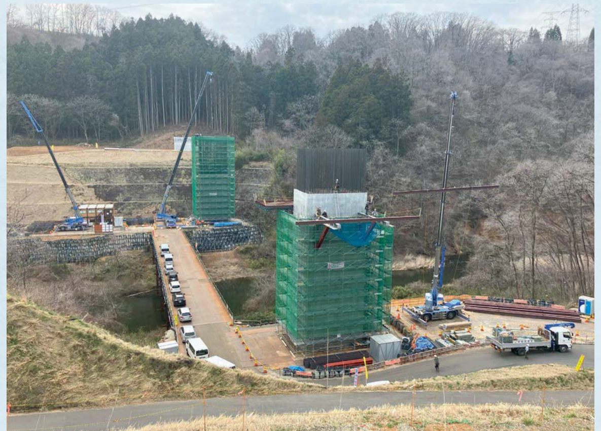
仙台市の工区。通称「1号橋」の現場。手前が赤石側、碁石川の向こうが川崎町側。全長207メートルの橋をかける。現在、橋脚2基、橋台2基が完成し、橋の桁工事に着手しています。来年3月の完成を目指しクレーン車3台が資材を移動中。なお、写真は3月10日に小山町長が撮影したもの。
